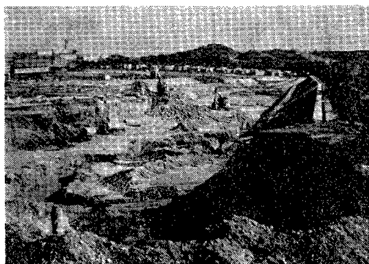
写真一5 多摩ニュータウン (面積3,020ha) 多摩センター付近の造成地で造成工事中に大雨が降った結果、元の谷を復元する形での加速的侵食がおこり、ガリが発達している。
